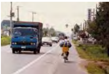
(整備前の歩道)
