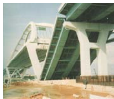
写真、阪神高速道路の落橋状況(西宮市甲子園浜)
