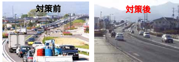
渋滞対策実施例(福島西道路4車線化)
