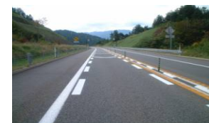
[導流レーンマーク]
