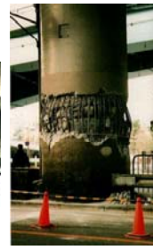
写真、阪神高速道路の橋脚の被災(神戸市長田区西尻池町)
