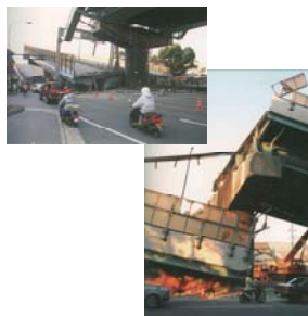
写真、阪神高速道路の落橋状況(西宮市浜脇町)
