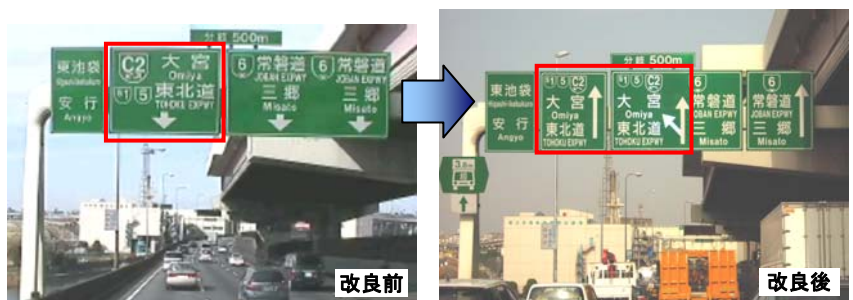
図14-4 中央車線は「大宮・東北道」方面、「常磐道・三郷」方面の両方に行けることを表示 (中央環状線(内回り)小菅JCT分岐部)
