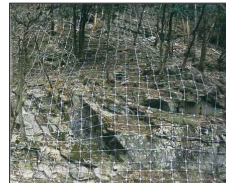
ロープネット工
