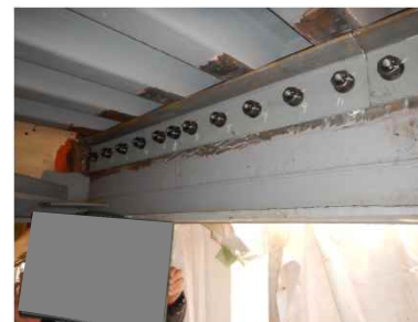
デッキプレートの補修
