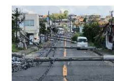
<電柱倒壊による道路閉塞>
