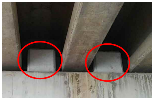
<変位制限装置の設置(主桁の横ずれ防止)>
