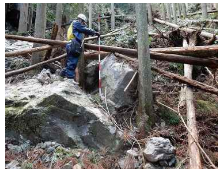
法面の岩塊状況
