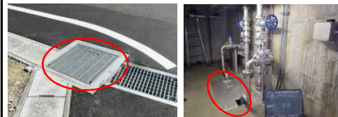
<排水施設> <排水ポンプ>
