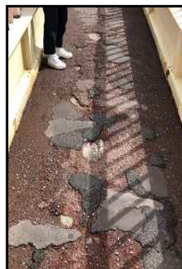
橋面舗装(常温合材等による補修の繰り返し)
