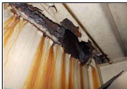
床版下面(デッキプレートの腐食・孔食)
