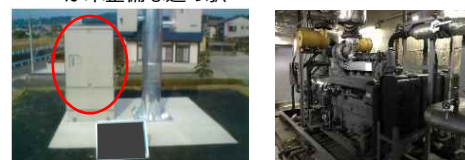
<無停電装置> <自家発電装置>
