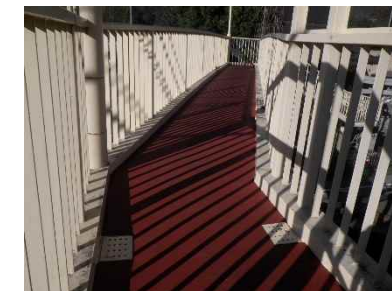
橋面舗装の補修
