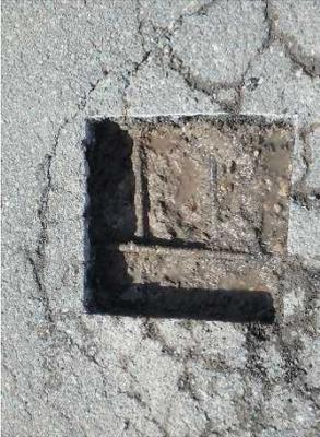
床版上面の土砂化
