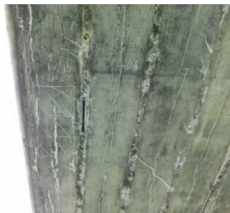
主桁のひび割れ
