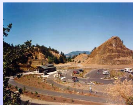
駐車場の整備
