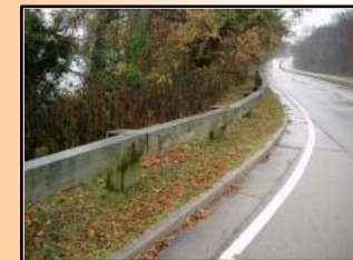
木製ガードレールの整備
