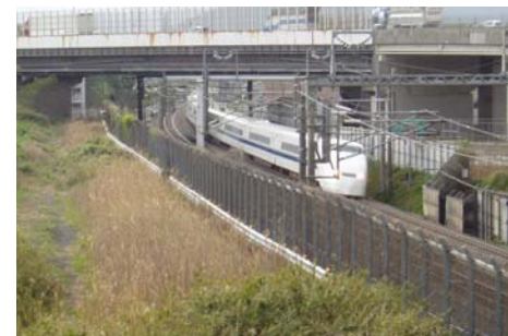
写真・東海道新幹線をまたぐ橋梁
