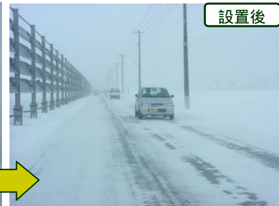
写真：防雪柵の設置による道路上の地吹雪の抑制
