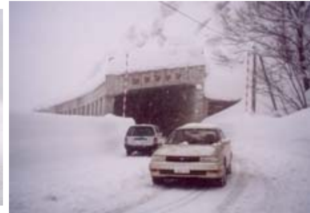
写真：スノーシェッド
