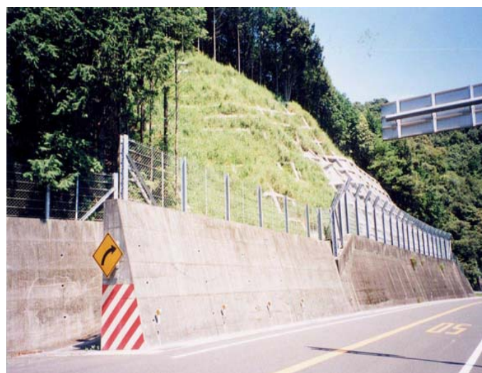
急斜面における防護柵工等の実施
