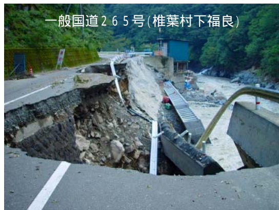
写真：平成17年台風14号による国道の被災状況 椎原村全体が一時孤立（1,274戸、平成17年9月5日～9月9日）
