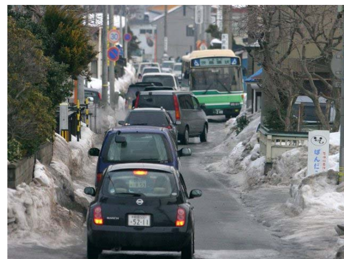
写真：路肩の堆雪によりすれ違いが困難になっている状況 (秋田県秋田市内の市道)
