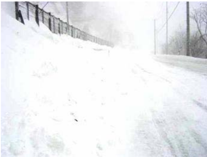
写真：雪崩による道路寸断状況 (岩手県雫石町内、国道46号)
