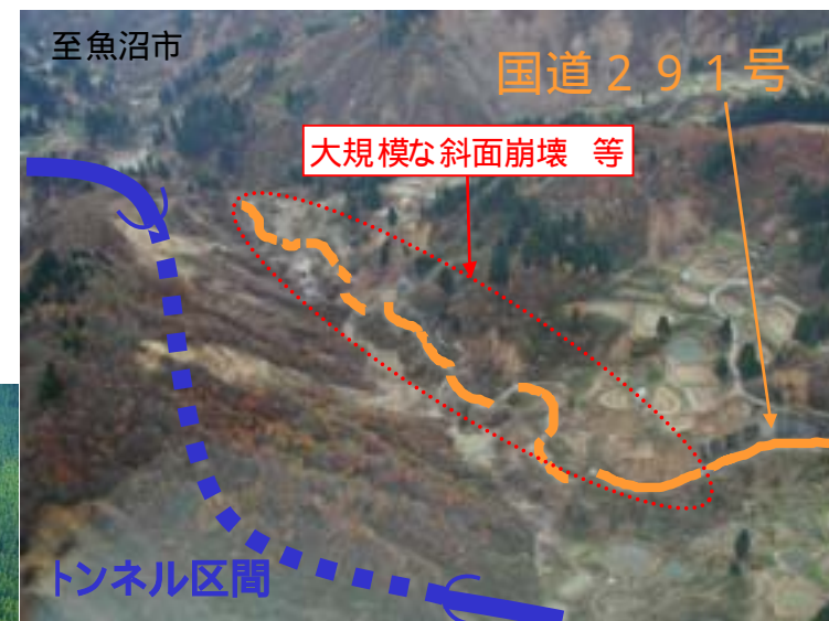
図：新潟県中越地震により大規模に被災した国道291号（直轄権限代行）
