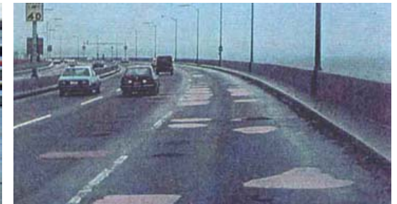
【有料橋の床版補修】
