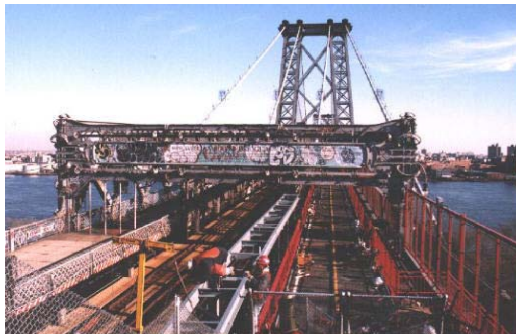
桁の取替え工事
