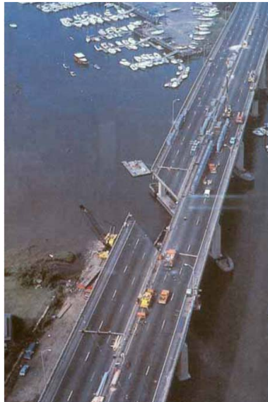
【マイアナス橋の崩壊の状況】
