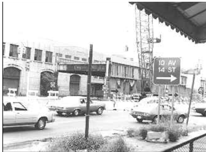
解体時の迂回交通
