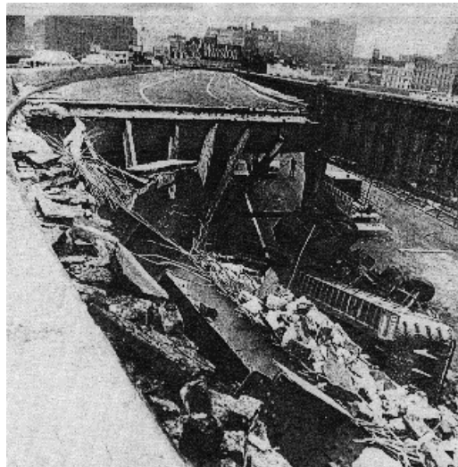
老朽化により解体
