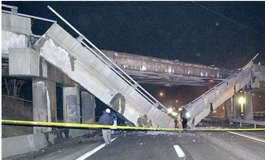
【I-70 コンクリート跨道橋崩壊の状況】
