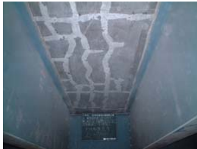
補強前(下地処理)
