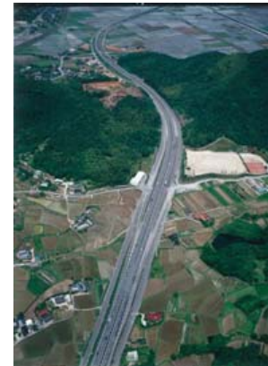
【小郡道路(延長13km)】 (建設費471億円)
