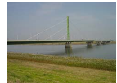
【水郷大橋(橋長535m)】 (建設費5億円)
