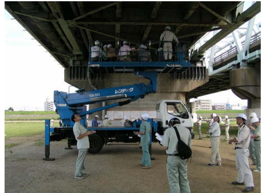
橋梁点検技術の实地研修
