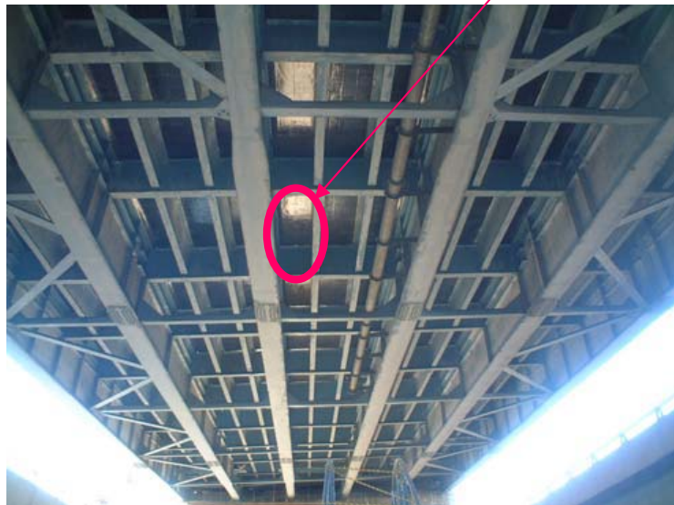
橋梁のRC床版の炭素繊維補強
