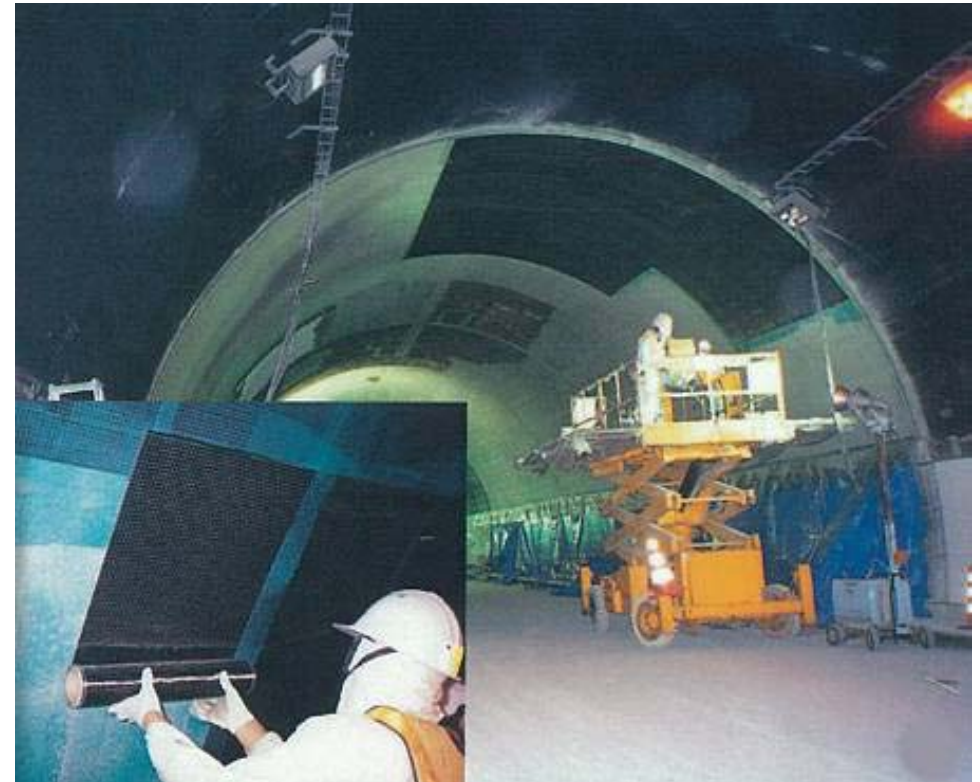
トンネル覆工コンクリートの炭素繊維補強
