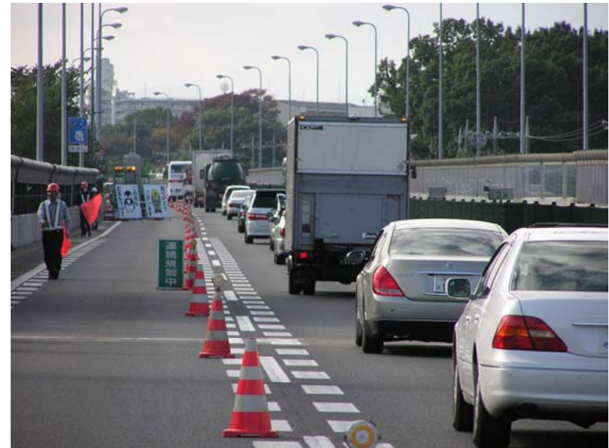
【中央道の補修工事による渋滞状況】
