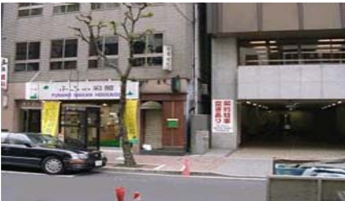
・メインストリートに面する駐車場が街並み分断、歩行環境悪化を招いている
