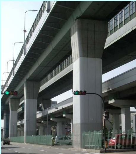
阪神高速道路の橋脚
