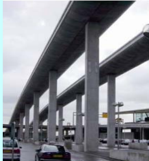
シャルル・ド・ゴール空港の アクセス道路の橋脚
