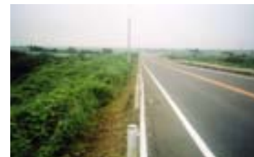
路肩部のみ除草
