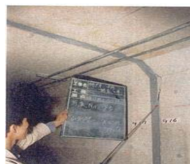
写真. 神戸市内の共同溝の状況
