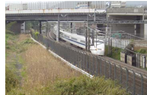
写真. 東海道新幹線をまたぐ橋梁
