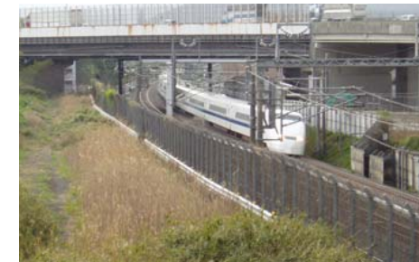
写真 東海道新幹線をまたぐ橋梁
