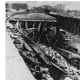
老朽化により解体 (1977年～1989年)
