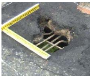
蛇淵橋(国道9号 兵庫県) 橋長: 137m 架設年: 昭和41年
