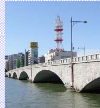
照明灯・橋側灯の復元
