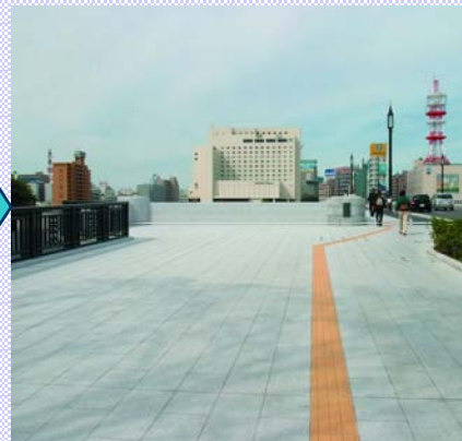
橋詰め広場の復元
