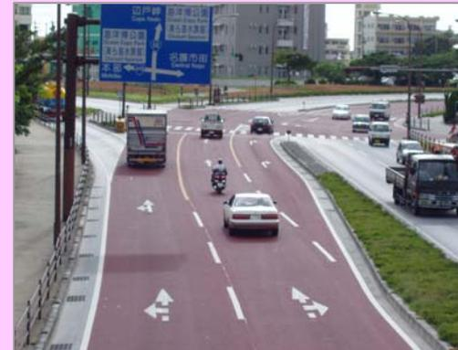
図 滑り止めカラー舗装による交差点改良 (国道58号名護市)
