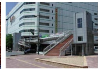
エレベーターの設置された歩道橋
