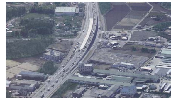
トラフィック機能に配慮した道路 (新4号国道)
