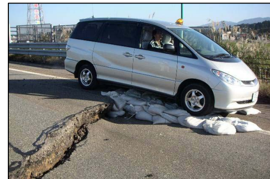
応急対策による緊急車両の通行確保(新潟県中越地震)
