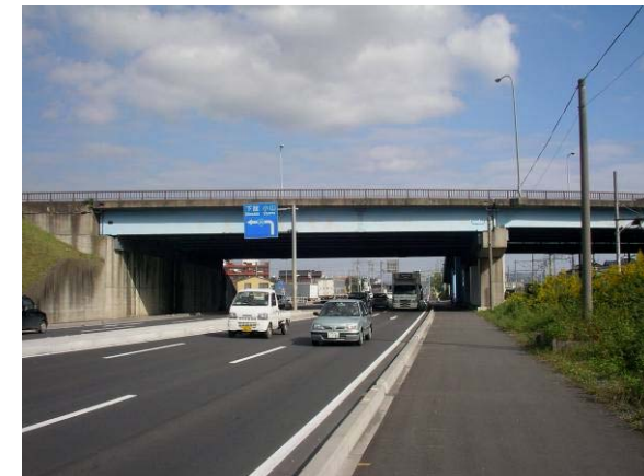
主要な幹線道路を跨ぐ橋梁
