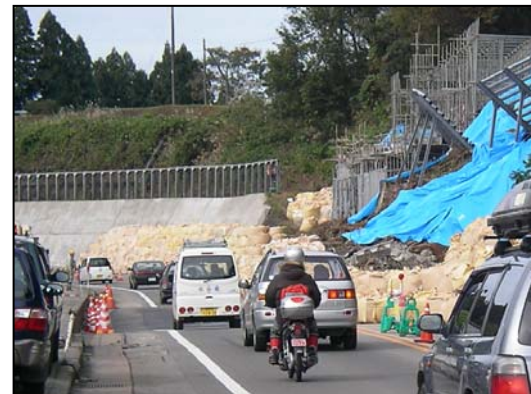
写真. 応急復旧により片側交互通行を確保(地震から2日後)
