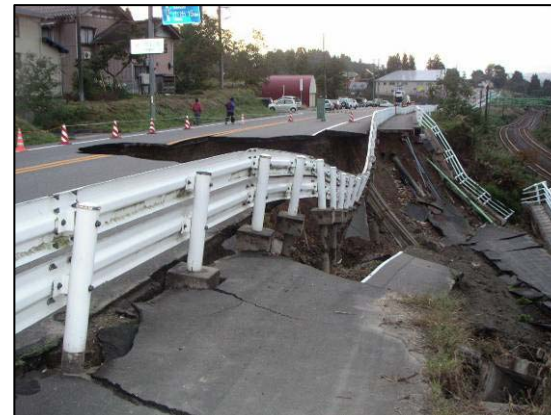
地震による橋梁以外の道路の被災事例(新潟県中越地震)
