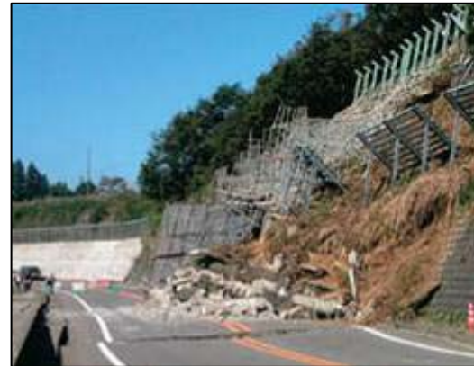
写真. 切土斜面の崩壊(国道17号)
