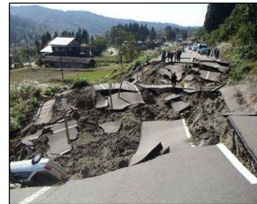
写真. 大規模な盛土崩壊(国道117号 新潟県管理)
