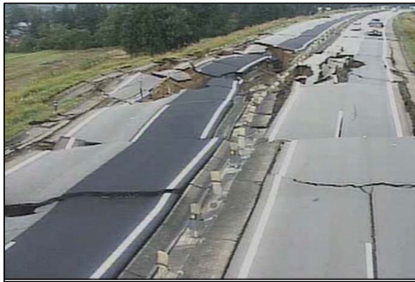
写真. 盛土の崩壊(関越道)
