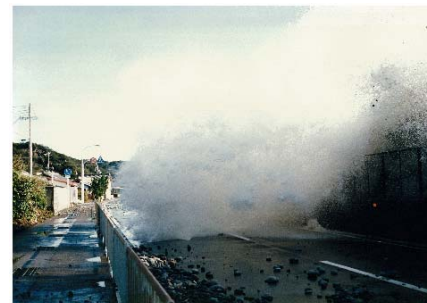
高波による通行止の状況 (平成9年9月)
