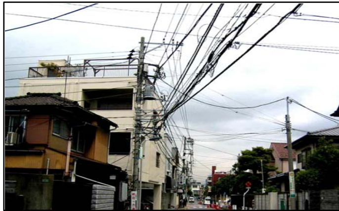
電線類により景観が損なわれている街なみ
