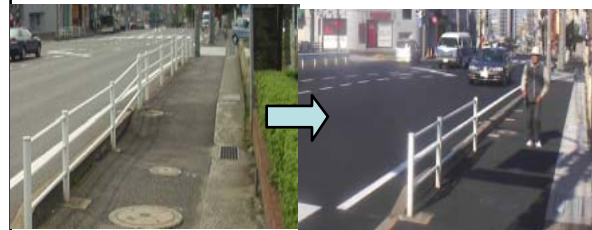
〔ニーズを反映した箇所で事業実施(歩道段差解消) (北九州国道)〕
