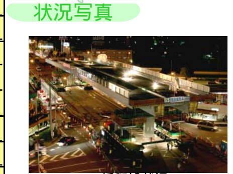
一括架設状況
