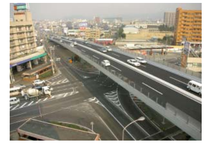
架設後の供用状況
