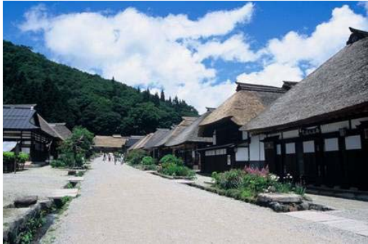
茅葺き屋根の葺き替え
