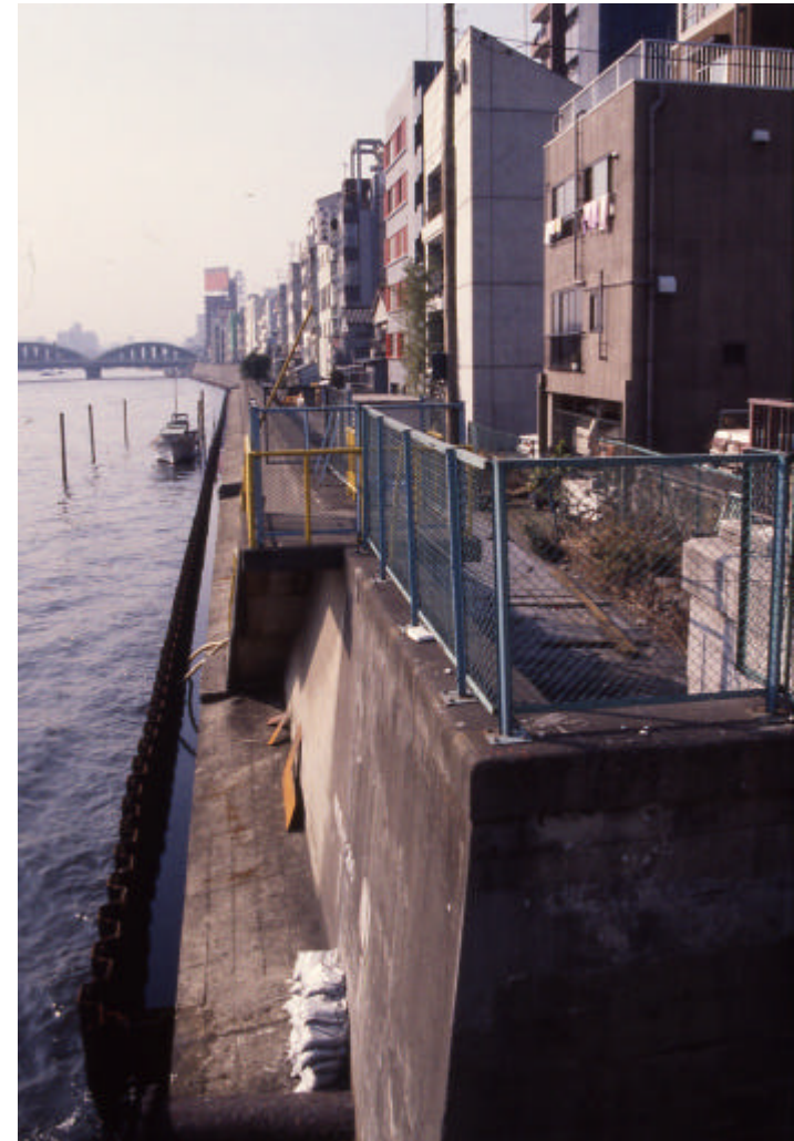
河川にお尻を向けた建物
