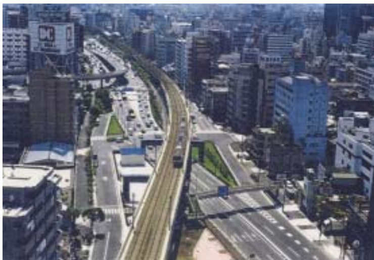
踏切21箇所を一挙に除却し、地域の渋滞を解消
