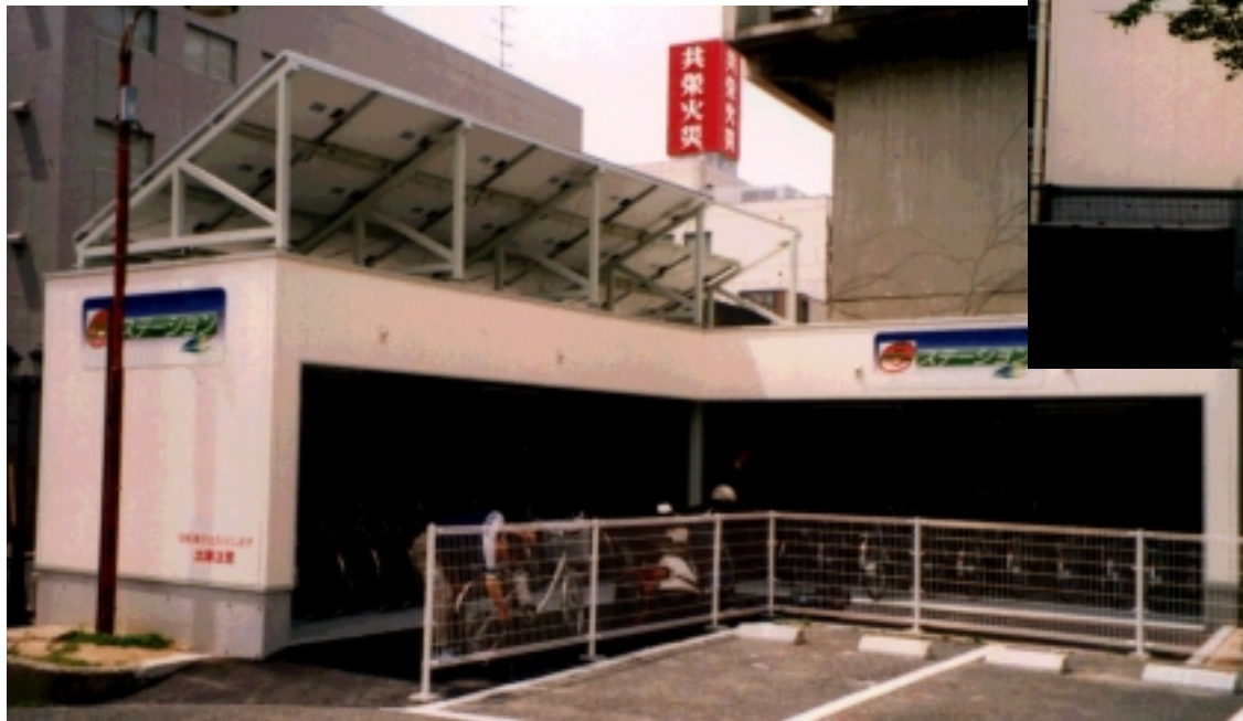
写真：太陽電池パネルによる電動アシスト 自転車の充電が可能な駐輪場 (山口県下関市)
