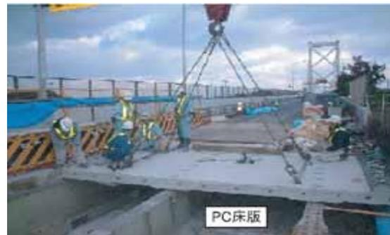
既存床版を撤去し、新しい床版(プレキャスト製)を現地に据え付ける工法
