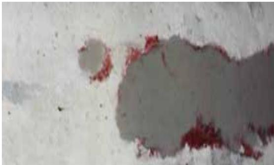
損傷部をはつり取り、モルタル等の修復材で埋め戻す工法
