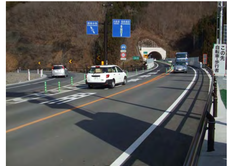
▲ 開通直後の唐桑道路(写真1)
