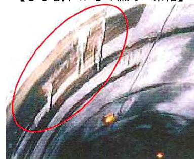
【ひび割れからの漏水・凍結】
