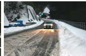
地芳トンネル愛媛県側坑口
