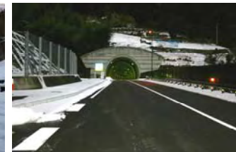
地芳トンネル高知県側坑口
