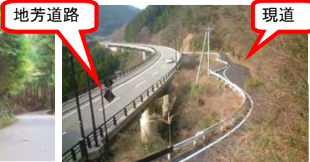
現道と地芳道路の状況
