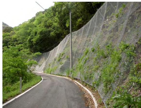
対策完了後（落石防止網）
