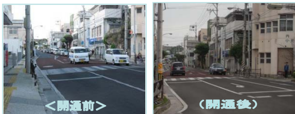
開通後の状況(糸満ロータリー交差点)
