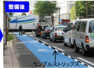
ランブルストリップス: 舗装路面を削り、車両に対して凹型を連続した注意喚起対策
