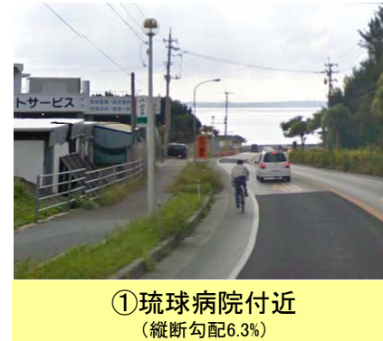
▲図2 現道(国道329号)区間における縦断線形不良箇所
