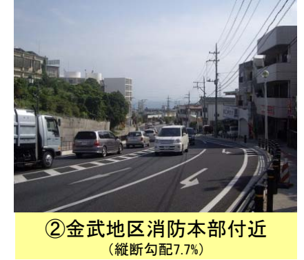
▲図2 現道(国道329号)区間における縦断線形不良箇所
