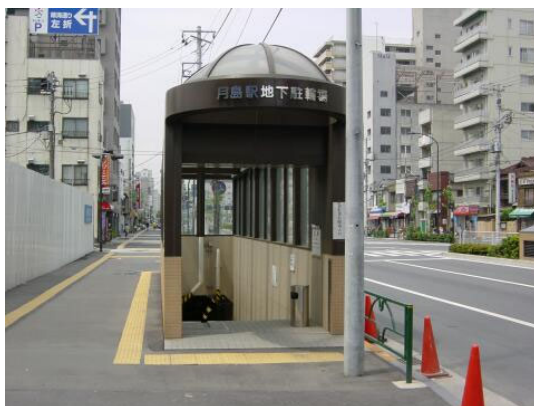
整備写真(地上)
