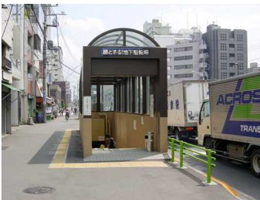
整備写真(地上)
