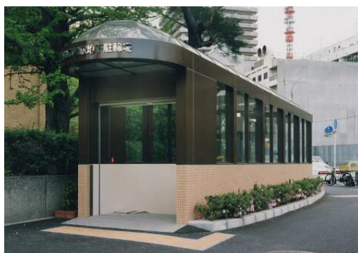
整備写真(地上)
