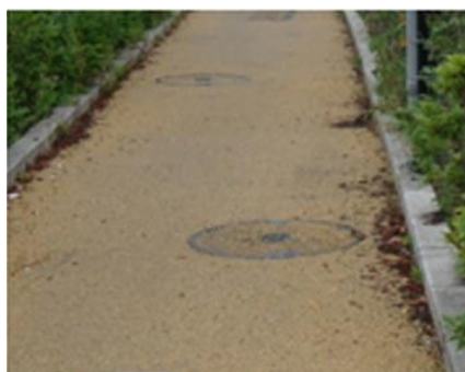
写真Ⅱ-4 マンホールの蓋に滑り止め加工した事例
