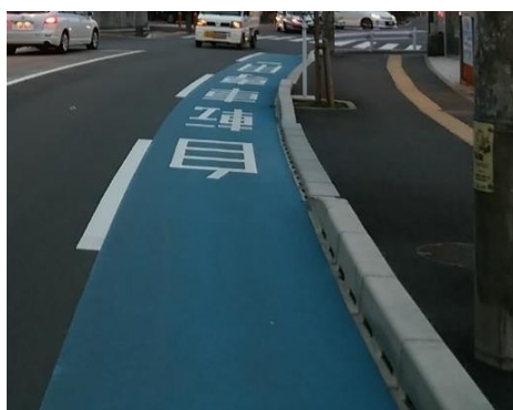
写真Ⅱ-1 エプロンの幅が狭く 平坦性の高い街渠に置き換えた事例
