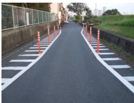
写真Ⅱ-11 自動車の速度を抑制するため、狭さくやシケインを設置した事例
