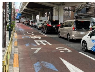
写真Ⅱ-8 バス専用通行帯を活用し矢羽根型路面表示等を設置した事例
