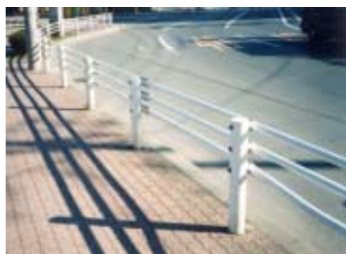
ボルト・ナット類が露出する等、裏面の処理が粗雑な防護柵の例
