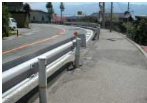
ボルト・ナット類が露出する等、裏面の処理が粗雑な防護柵の例
