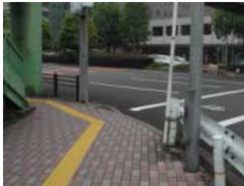
隣接して設置された防護柵の色彩、形状が異なるため、煩雑な印象となっている例
