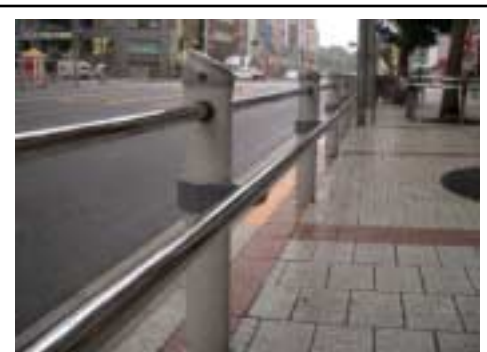
手すりともなるビームを取り付けた例
