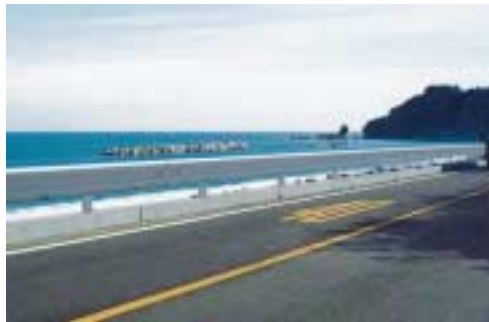
防護柵更新前の状況
