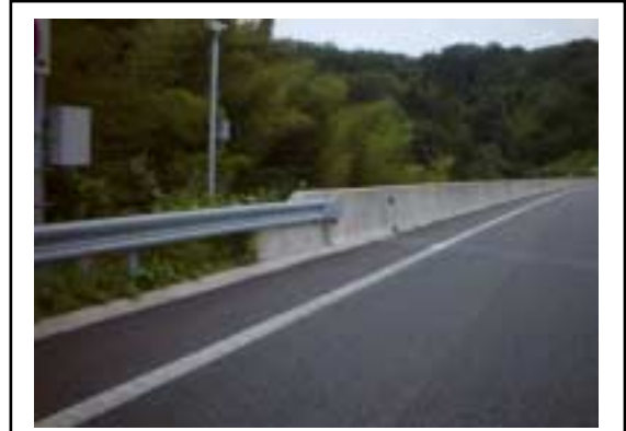
剛性防護柵とたわみ性防護柵との接合部の連続性を確保している
