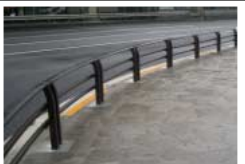
防護柵の上端に設置されたトップビームが支柱の頂部を覆っているため、歩道側から見たときに、裏側であることの印象が緩和されている
