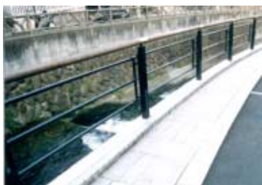
転落防止柵のトップビームを木製として手触り感を良くした例
