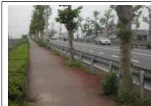
歩道から見ると、裏面としての印象が強い
