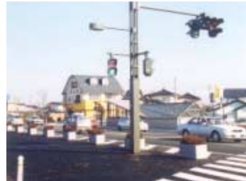
暫定供用時において、プランターを設置し、車両の誘導を行っている例
