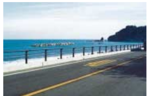
防護柵更新後の状況
