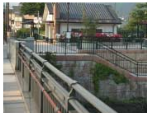
高欄に木製の手すりを取り付けた例
