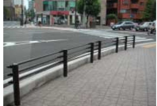
防護柵の支柱間隔がみだりに変わると、煩雑な印象となる。
