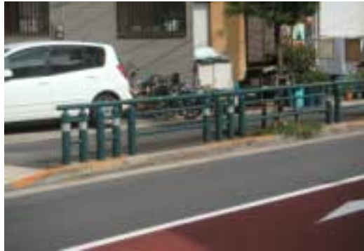
防護柵の支柱間隔がみだりに変わると、煩雑な印象となる。
