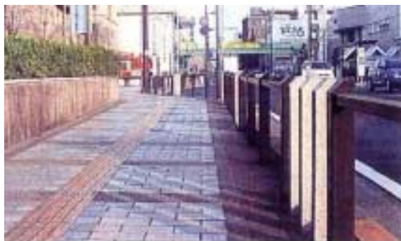
防護柵に御影石を併用した例 防護柵の変形や破損に際し、迅速な修繕・ 復旧が難しい
