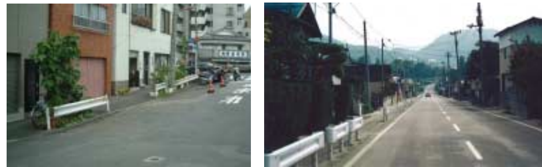
車両用防護柵が断続的に設置された例 車両の路外逸脱防止・進行方向復元といった車両用防護柵としての機能が果たされていない
