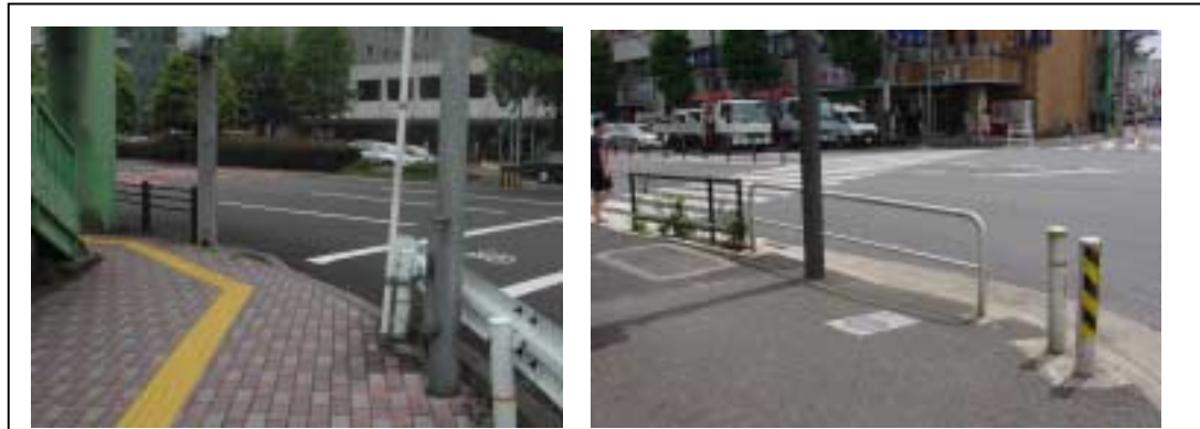
隣接して設置された防護柵の色彩、形状が異なるため、煩雑な印象となっている例
