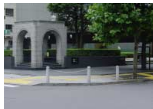
交差点内での歩行者等の乱横断防止柵のために設置された防護柵は、ポラードとチェー ンの組み合わせで代替可能
