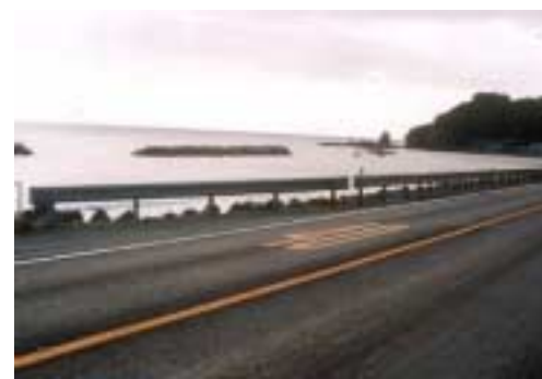
防護柵更新前の状況
