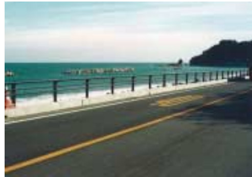
防護柵更新後の状況 防護柵の透過性が高く、眺望に優れている
