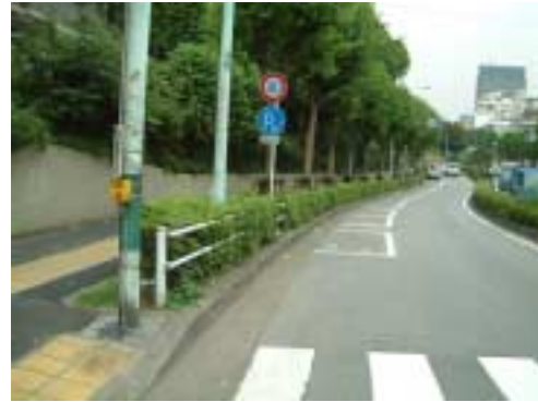
植栽帯と横断防止柵を併用した例 植栽帯により歩行者の横断防止機能が確保されているため、防護柵は必ずしも必要ない
