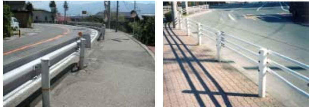
ボルト・ナット類が露出するなど、裏面の処理が粗雑な防護柵の例
