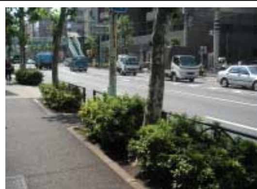
植栽帯と横断防止柵とが併用されている例 横断防止柵設置の必要性はない
