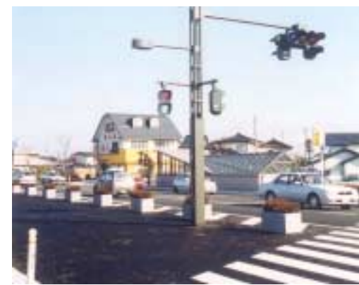
暫定供用時において、プランターを設置し、車両の誘導を行っている例
