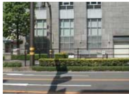
植栽帯と横断防止柵を併用した例 植栽帯により歩行者の横断防止機能が確保されているため、防護柵は必ずしも必要ない
