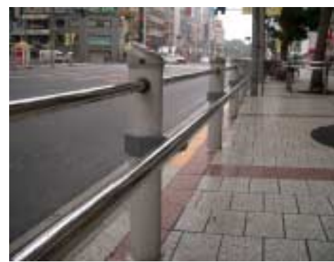
手すりともなるビームを取り付けた例
