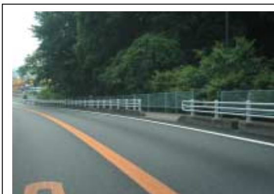
車両用防護柵(歩車道境界)と転落防止柵(歩道路側)の色彩が異なるため、煩雑な印象となっている
