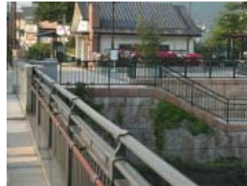
高欄に木製の手すりを取り付けた例
