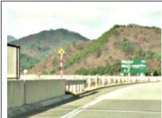
剛性防護柵とたわみ性防護柵との接合部の連続性を確保している
