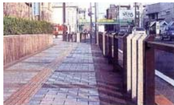
防護柵に御影石を併用した例 防護柵の変形や破損に際し、迅速な修繕・復旧が難しい
