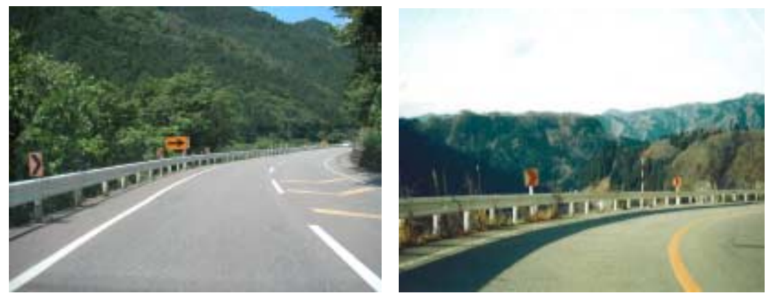
危険箇所における白色のガードレールは、道路線形を明示し、視線誘導効果が高いが、外部への眺望を阻害するとともに、周辺景観の中で浮立った存在になりやすい。
