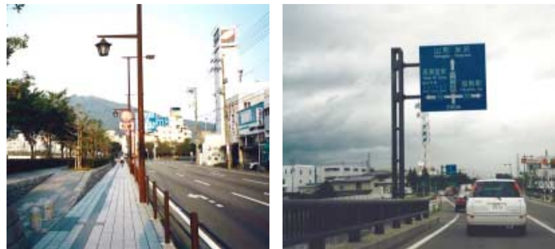
左写真：照明柱と防護柵の色彩の統一を図った例、右写真：標識柱と防護柵(高欄)の色彩の統一を図った例
