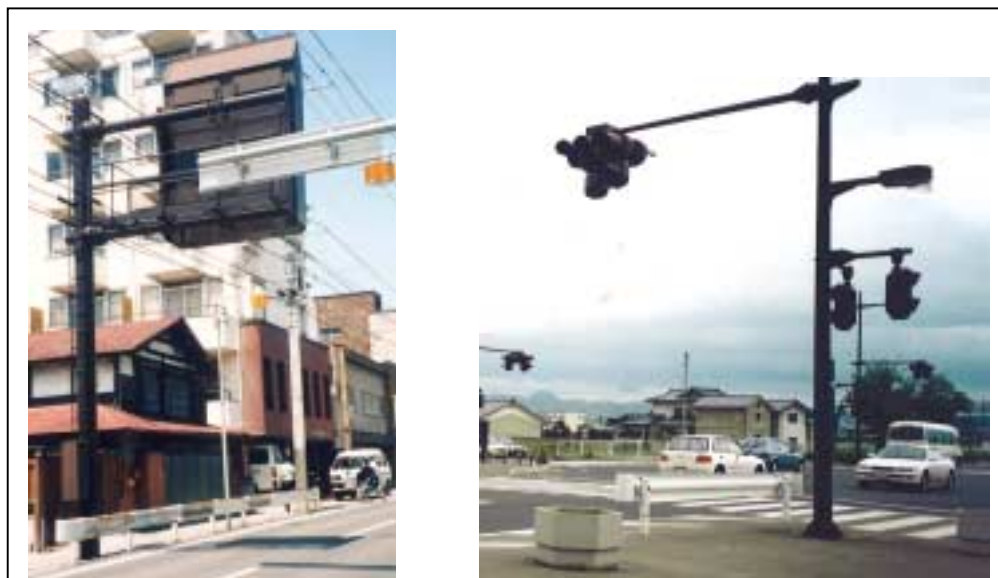
防護柵と照明柱、信号柱、標識柱の意匠、色彩が異なるため、煩雑な印象となっている例
