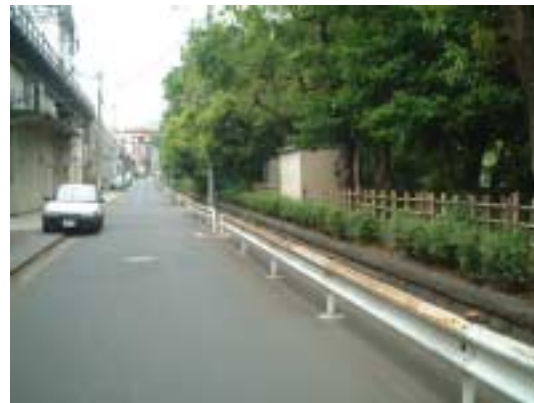
錆びが目立ちはじめしており、視線誘導効果も低下しつつある
