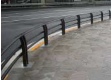
防護柵の上端に設置されたトップビームが支柱の頂部を覆っているため、歩道側から見たときに、裏側であることの印象が緩和されている
