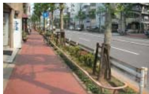
錆や汚れが目立つ防護柵の例
