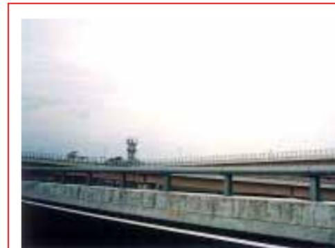
コンクリート製の壁型剛性防護柵の上部に、金属製のトップレールを付加した複合型の形式の例
