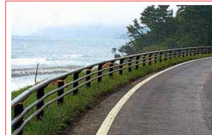
防護柵の支柱に反射シートを巻き付けることにより、視線誘導を確保している例
