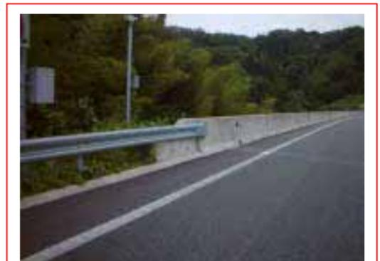
剛性防護柵とたわみ性防護柵との接合部の連続性を確保している
