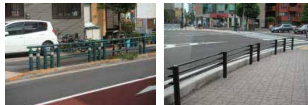
防護柵の支柱間隔がみだりに変わると、煩雑な印象となる。
