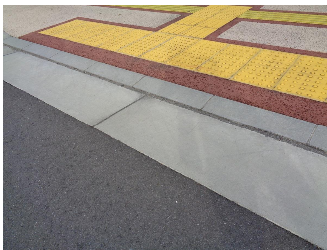
写真 2-1-7 縁端高さ 1cm から背面高さ 3cm 構造の歩車道境界
