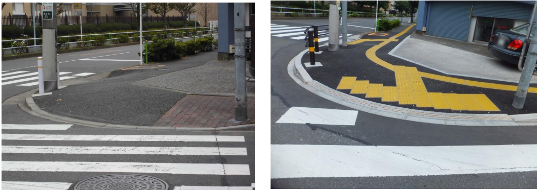
写真 2-1-6 整備前交差点（左）・整備後交差点（右）
