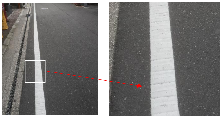
写真 2-1-25 単断面道路のリブ式の車道外側線 (大阪府豊中市府道豊中吹田線：特定道路)
