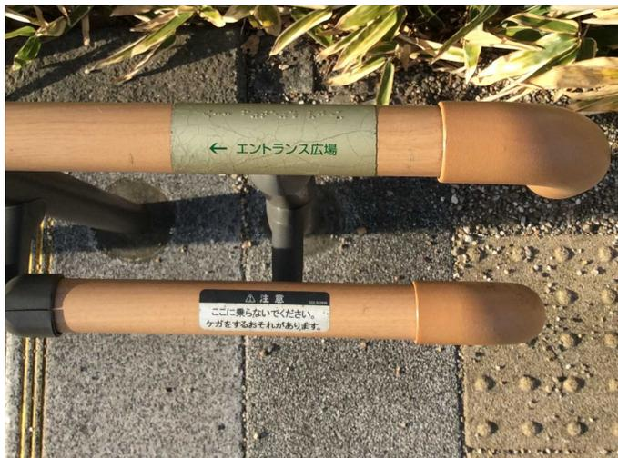
図 2-2-10 手すりの点字・文字の設置位置と例
