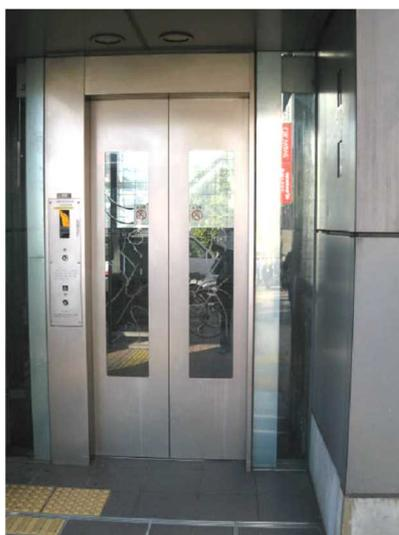
写真 2-2-3 乗降口の操作盤設置例
