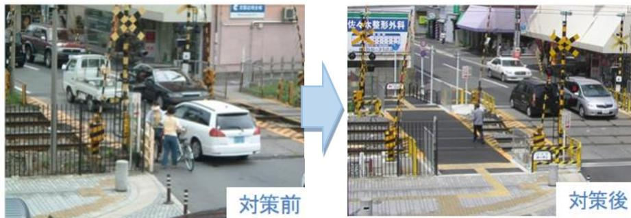
写真 2-7-23 踏切拡幅（歩道新設）の事例
