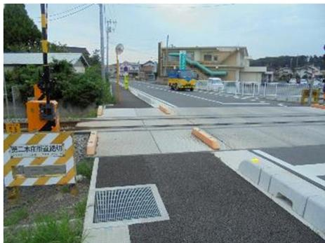
写真 2-7-31 ブロック等により分離している例
