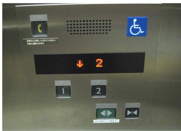
写真 2-2-2 籠内側面の操作盤設置例
