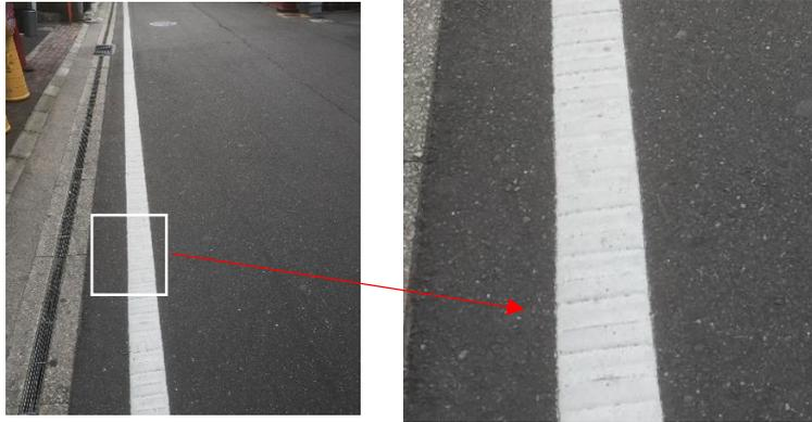
写真 2-1-25 単断面道路のリブ式の車道外側線
