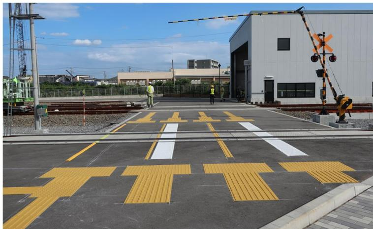
写真 2-7-19 本実験の誘導表示等の敷設状況
