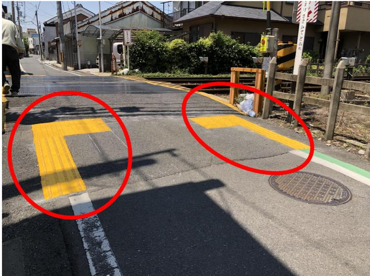
写真 2-7-16 視覚障害者誘導用ブロックを車道上に設置した事例
