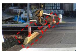
踏切道端部のブロック、ラバーボール及び路面標示の設置事例
