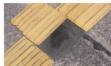
ブロックがはがれていたり、摩耗・破損したりしている
