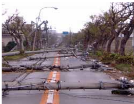
< 電柱の倒壊による道路閉塞 >
