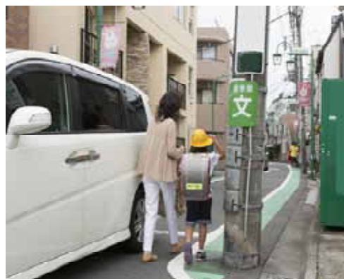
< 歩行の支障となる電柱 >
