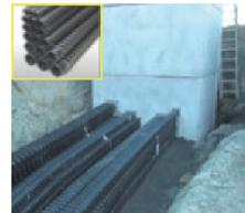
安価で弾性がある角型多条電線管を地下に埋設
