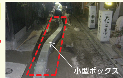
整備中の状況
